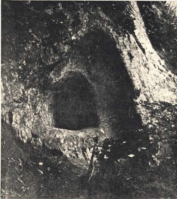
Розгірче 6. Зовнішній вигляд вікна в пресвітерії церкви
